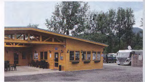
Das Versorgungsgebäude mit Rezeption, Aufenthaltsraum und Sanitäreanlagen.
